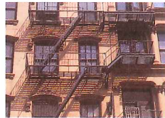
fire escape thang thoát hiểm 消防通道 xiāofángtōngdào
